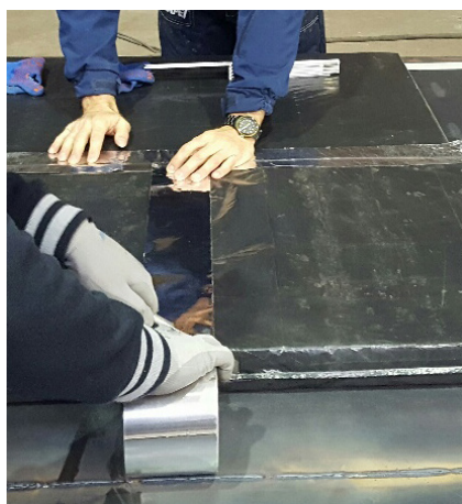
Sigillare i giunti con nastro in alluminio Seal the joints with aluminum tape
